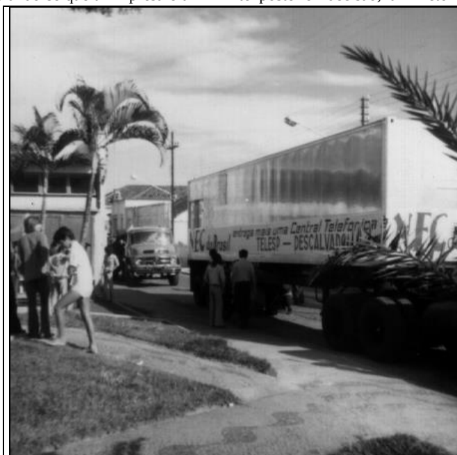
Chegada do container abrigando a central telefônica com 1.000 linhas
